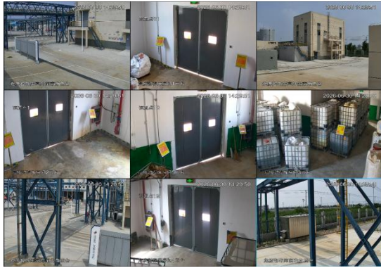
危废库监控画面
